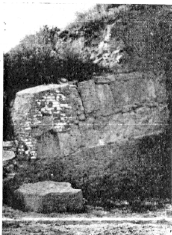
Fig. 6. - Muraglione di sinistra del piazzaleto.
